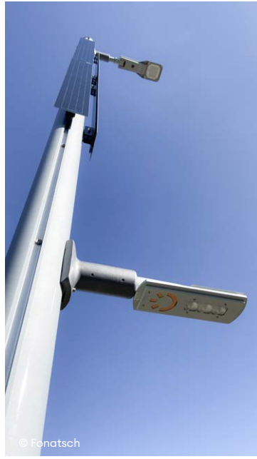
Blackout Versorgungsmasten – Licht und Anzeigen bei Stromausfall
